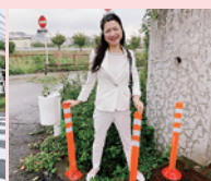
市ケ尾町側溝に転落防止策の設置
